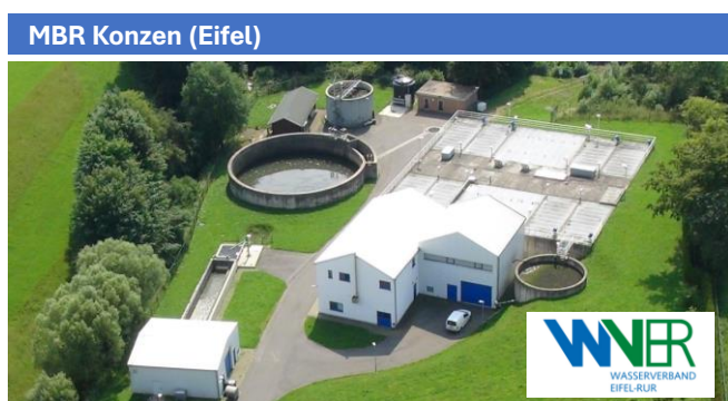
Bild 1: Die Membrankläranlage Konzen
